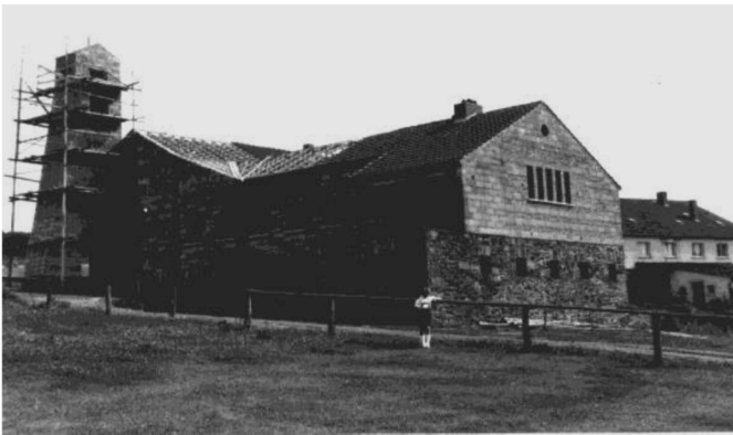
Die Kirche im Rohbau
