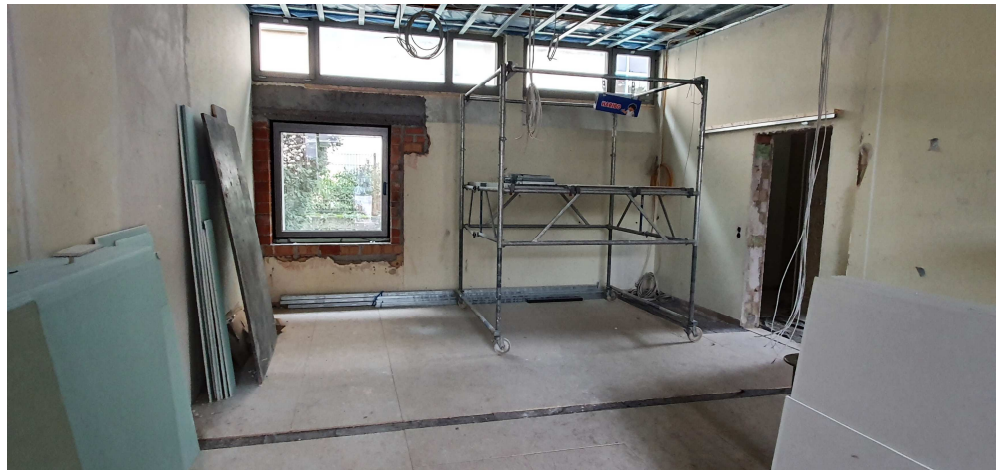
Zentrales Pfarrbüro im ehemaligen Flur, es fehlt noch die Zwischenwand
