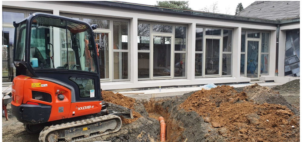
Die neue Fensterfront, Baggerarbeiten im Innenhof
