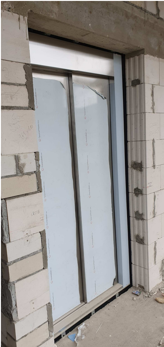
Neuer Aufzug zum Pfarrsaal
