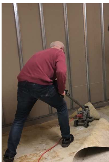
Stefan Schmid entsorgt den alten Fußboden mit dem ausgeliehenen Schaumbelagsentferner.
